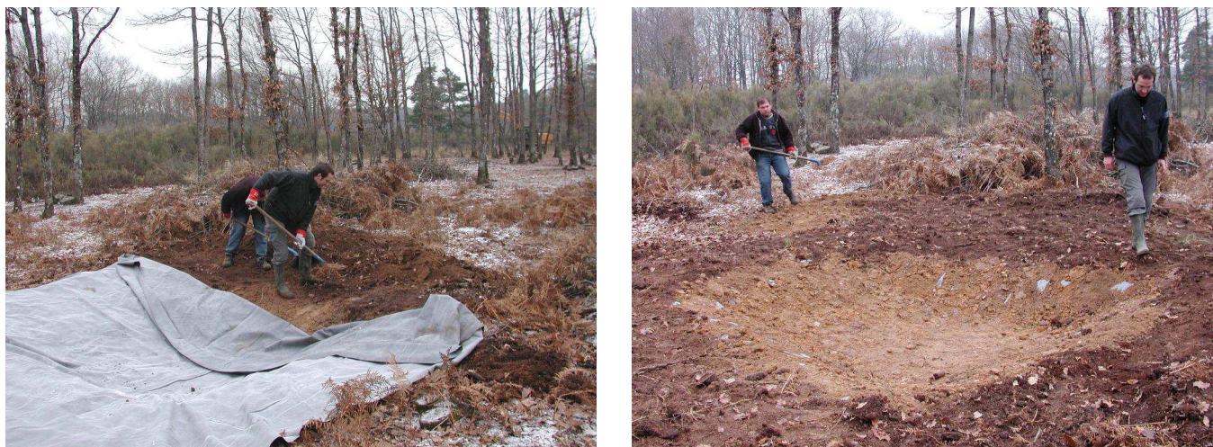
Figure 12 : Travaux de creusement d'une mare à Chitré
